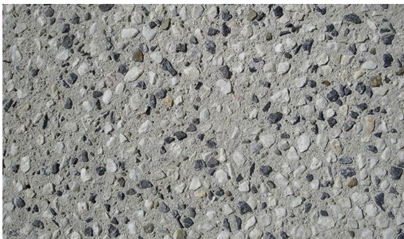
Béton désactivé teinte gris moucheté (mise en œuvre îlot central)
